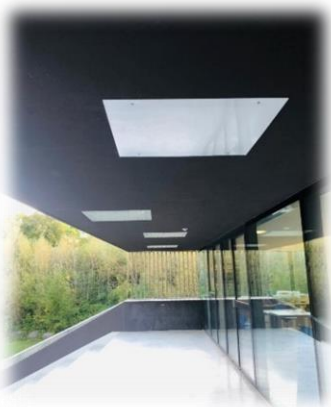
Figure 23 : Grille "garde-corps" haut des escaliers et nouveaux caches-néons
