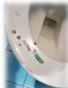
Figure 33 : WC garçons - cercle cuvette brûlé
