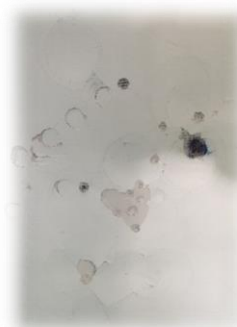
Figure 30 : salle de classe 309 - mur du fond
