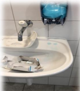
Figure 32 : WC garçons - porte-savon détruit
