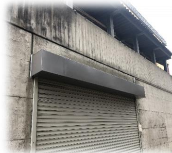
Figure 19 : remplacement caisson
