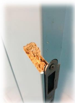
Figure 34 : poignée et serrure arrachées
