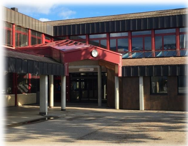
Figure 9 : Entrée principale - collège L'Oujon
