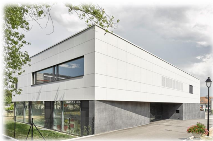
Figure 21 : Bâtiment de l'Enfance - Photo tirée de www.coretra.ch
