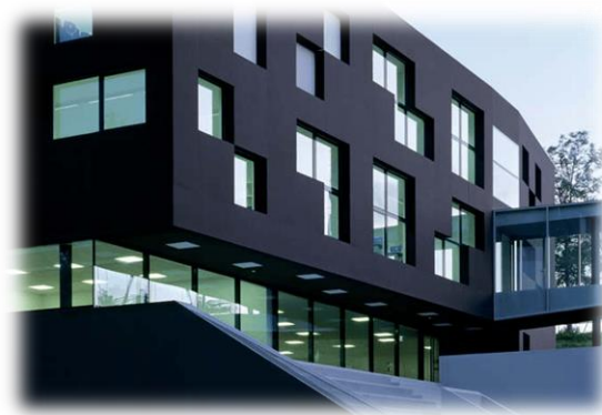
Figure 17 : Collège Le Cordex – image tirée de : architecte.ch
