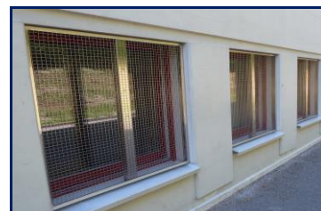
Figure 10 : fenêtres vestiaire des maîtres
