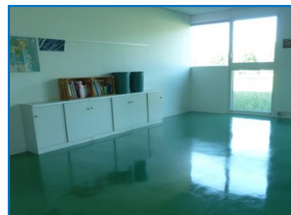
Figure 14 : Collège Le Cordex Salle de classe-sol linoléum refait
