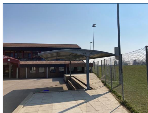
Figure 14 : Préau couvert avec accès au terrain
