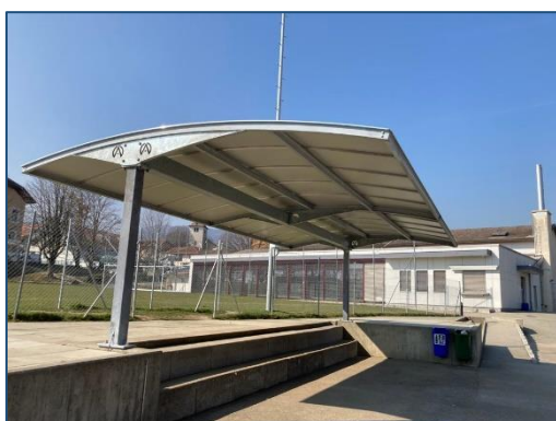
Figure 13 : Préau couvert avec accès au terrain
