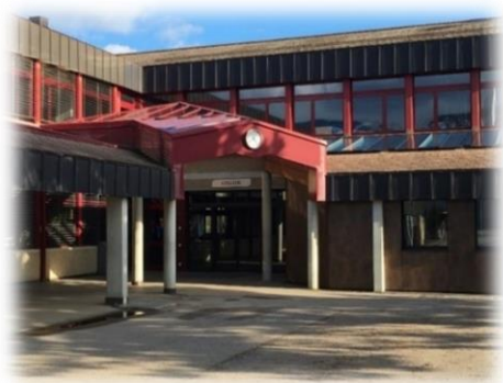
Figure 1 : L'Oujon - entrée principale
